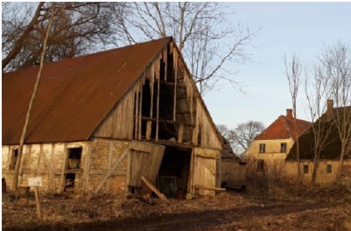
Billede af en tidligere nedrivningssag i kommunen.
